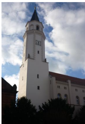
Wieża ratuszowa w Kątach Wrocławskich fot. Piotr Krajewski
