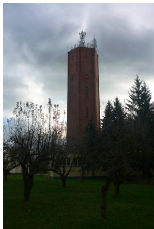
Wieża ciśnienia przy ulicy Popieluszki fot. Piotr Krajewski
